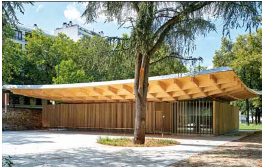
Der Umkleide-Pavillon mit seinem auskragenden Dach. Fotos: Michel Denancé (2)
