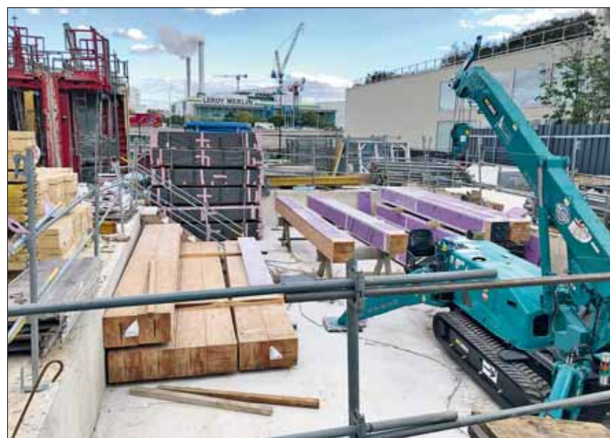
Die sichtbaren Stützen aus Douglasie werden auf der Baustelle eingepackt – bevor sie nach und nach aufgestellt werden und später hinter Glas geschützt liegen. Im Hintergrund ist die gut verpackte BSH-Lieferung aus Buche erkennbar. Foto: jt
