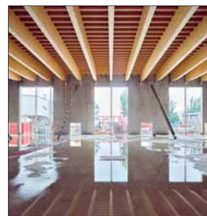
Die Paris Arena im Bau – noch sieht man das verwendete Holz.
