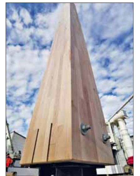
Prototyp der Stützen aus Buchen-BSH für das Projekt „Wood Up“ in Paris.
