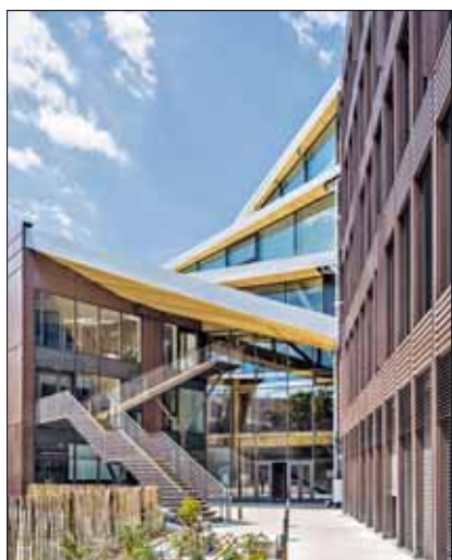
Ein Hauptpfeiler verteilt die Dächer wie ein Baum seine Äste.
