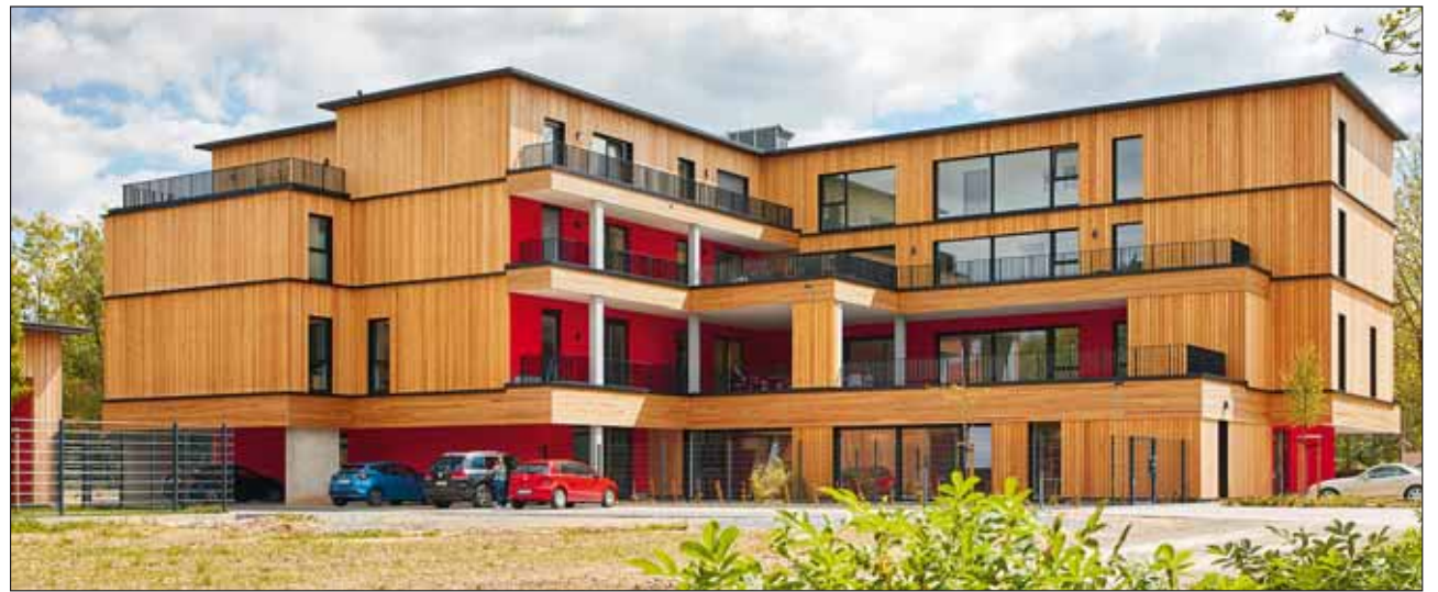
Dieses viergeschossige Mehrgenerationenhaus in Bad Oeynhausen wurde in Brettsperrholzbauweise erstellt, deren Elemente von Derix produziert wurden. Das Bauwerk ist einer der Preisträger des „Holzbaupreises NRW 2022“, der im Rahmen des Kongresses verliehen wurde. Foto: Derix-Gruppe
