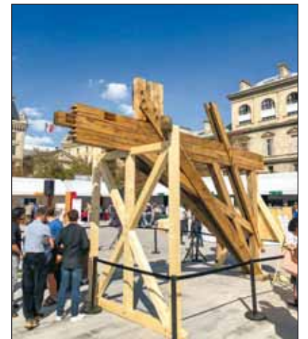
Sockel des Vierungsturms im Maßstab 1:2. Im Herbst 2021 wurden zwei konkurrierenden Unternehmensgruppen gebeten, ihr Können unter Beweis zu stellen. 570 Stunden Arbeit brauchten die Bewerber um Le Bras, um diese Konstruktion herzustellen. Foto: jt
