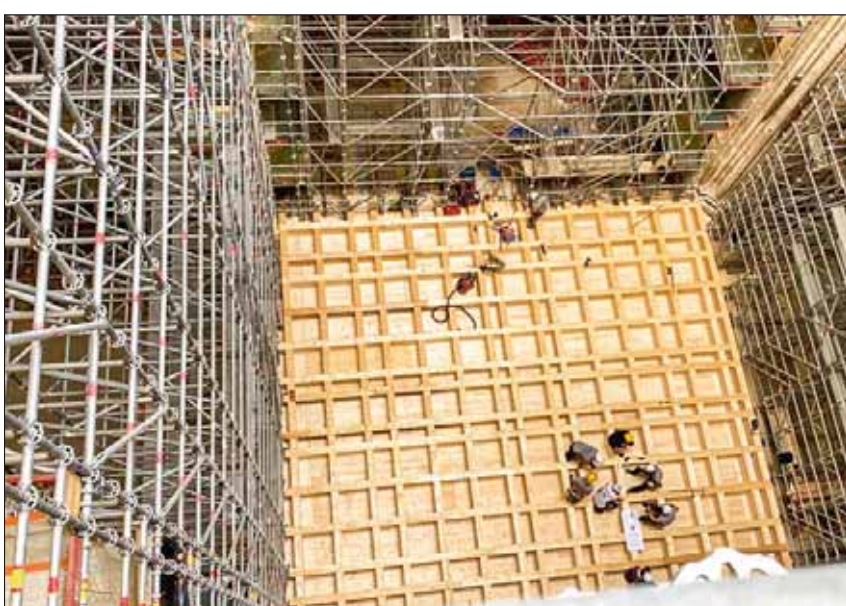
Aufbau des Gerüstsockels aus Holz
