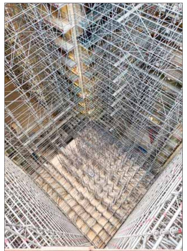
Beginn der Aufstockung des Gerüsts für den Vierungsturm
