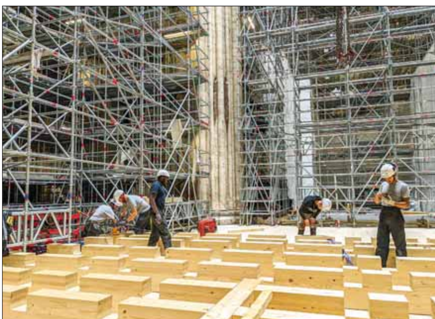
Aufbau des Gerüstsockels aus Holz
