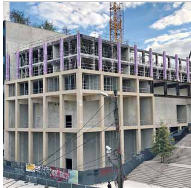
Die drei ersten Etagen des Projekts „Wood Up“ sind aus Beton, darüber erhebt sich der Holzturm mit BSH-Stützen – aus Douglasie im Fassadenbereich, dahinter aus Buche. Foto: jt
