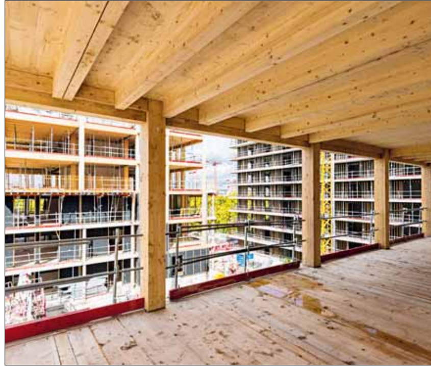
Baustelle im Olympischen Dorf Ende September: Noch sind die Holzelemente gut erkennbar – aufgrund geltender Brandschutzbestimmungen werden sie in den fertiggestellten Gebäuden weitgehend unsichtbar sein. Foto: Solideo/Cyril Badet
