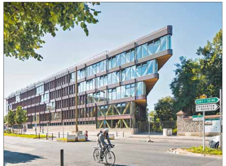
Der neue Hauptsitz in Maisons-Alfort, Nordfassade: Die Staffelung der Etagen-Überhänge schafft ein Vordach für den Haupteingang.
