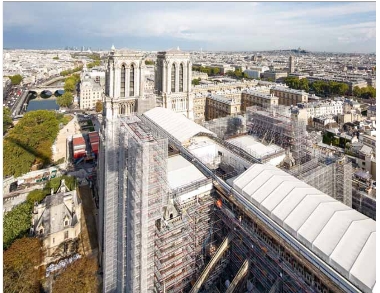
Stand der Wiederaufbauarbeiten an der Kathedrale Notre-Dame in Paris im September dieses Jahres
